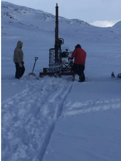
Bilde 2 Viser borerigg som ble benytte til å bore hull til teinene.
